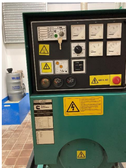
Foto 7 – Záložní dieselagregát.
