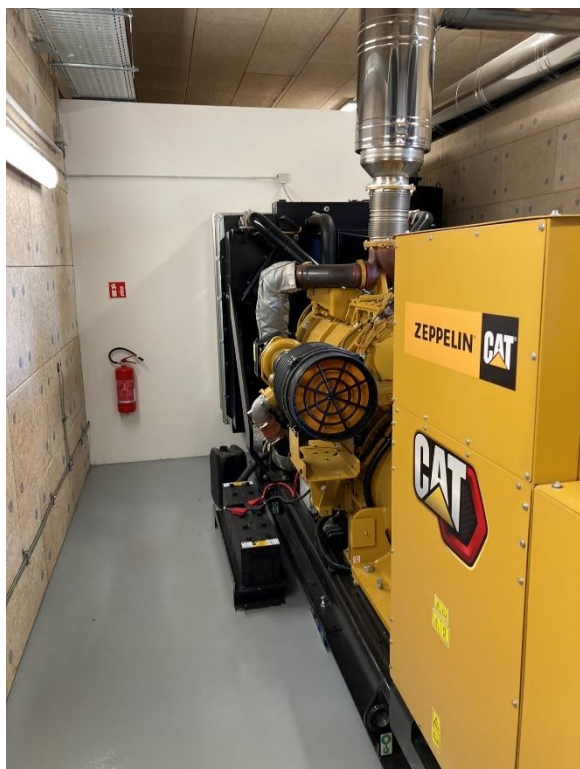
Foto 5 – Záložní diesel generátor r.v. 2020 ve strojovně náhradního zdroje.
