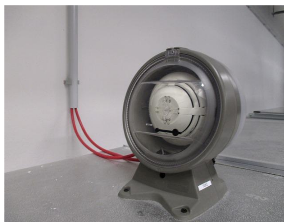
Foto 10 – Detekce kouře ve VZT (foto z r. 2016).
