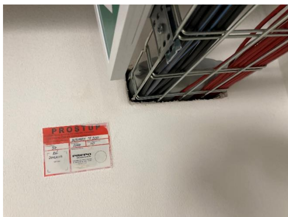
Foto 9 – Požární prostup v budově E s protipožárním sáčkem na grafitové bázi Intumex PS.
