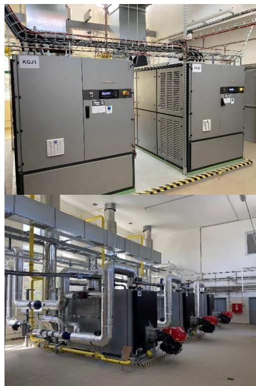
Foto 6 – Nové kogenerační jednotky a plynové kotle v nově zrekonstruované kotelně – budova K.
