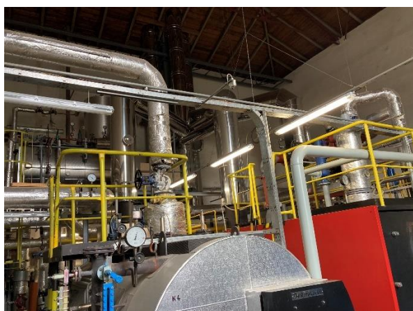
Foto 3 – Centrální plynová kotelna – 2 kotle teplovodní, jeden parní pro provoz prádelny.
