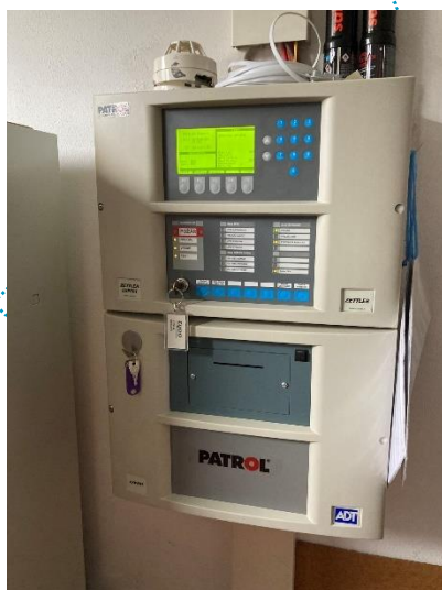
Foto 5 – Ústředna EPS na vrátnici budovy C.
