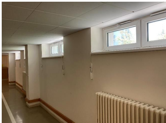
Foto 9 – Větrání CHCÚ ovládané EPS.
